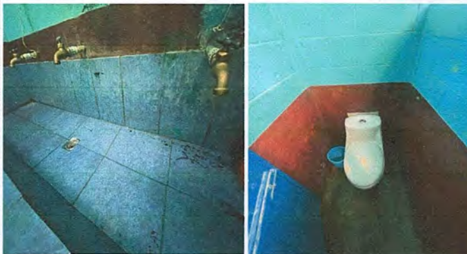
Foto 4: Mejoramiento de servicio sanitarios con tasas sanitarias lavables.
