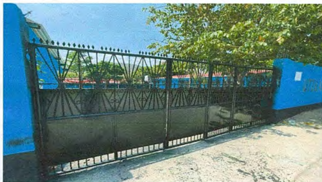
Foto 3: Mantenimiento de Portón de 12M.
